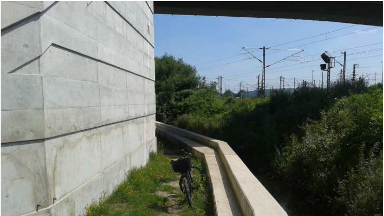
Der Haseuferweg endet bislang an der Schellenbergbrücke. Noch in diesem Jahr soll weiter gebaut werden. Foto: Lahmann-Lammert
