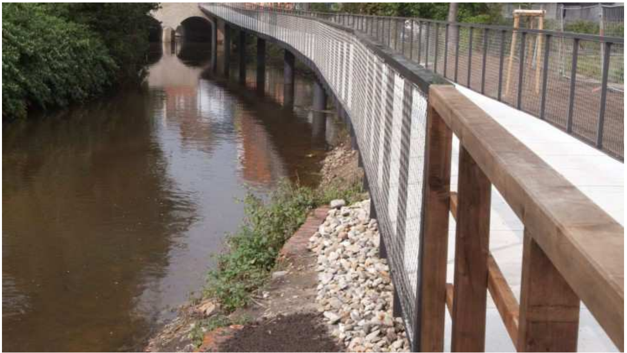
Stelzenkonstruktion: Die neue Etappe führt von der Neuen Mühle bis zur Schlagvorder Straße. Foto: Michael Hehmann
